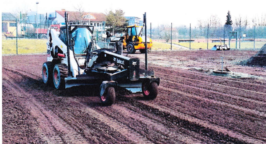
Einbau der dynamischen Schicht mit unserem Laser-gesteuerten Grader
